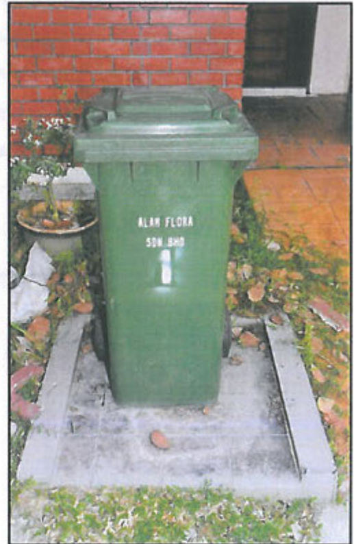
Gambar 6-8 : Penyediaan tapak tong bagi menempatkan 1 unit tong beroda mudah alih (MGB) 120 liter
