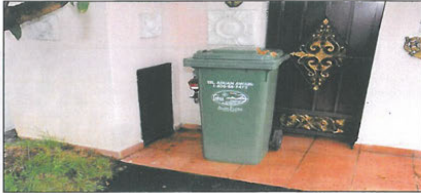
Gambar 2-5 : Kebuk sampah yang dibina tidak dapat memuatkan tong beroda mudah alih 120 liter
