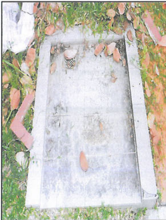
Gambar 6-8 : Penyediaan tapak tong bagi menempatkan 1 unit tong beroda mudah alih (MGB) 120 liter
