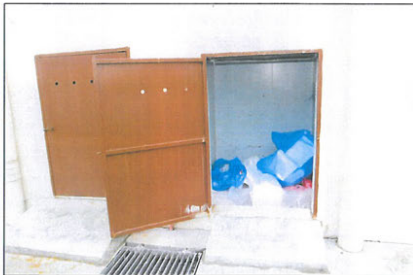
Gambar 6-6 : Kebuk sampah di belakang rumah kedai/kedai pejabat yang boleh memuatkan 1 unit tong MGB 240 liter
