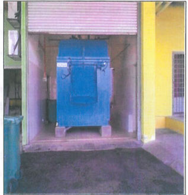
Gambar 6-2 : Pusat pemungutan sisa pepejal menggunakan spiral waste bin
