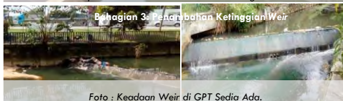
Foto : Keadaan Weir di GPT Sedia Ada.
